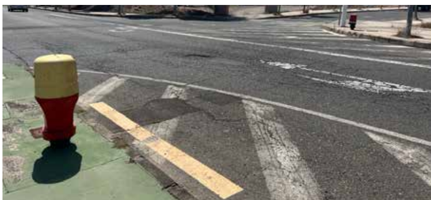
Hidrantes señalizados con prohibición de estacionamiento
