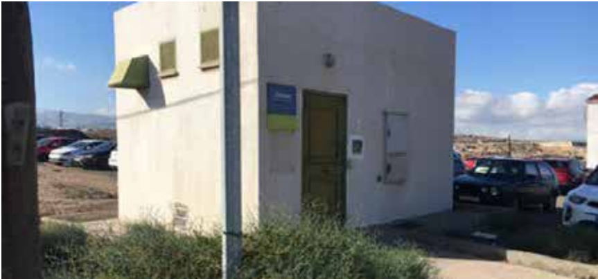
Estación de telecomunicación compañía Telefónica.
