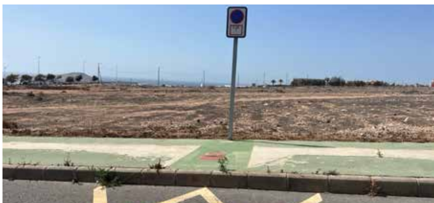
Arqueta hidrante enterrado señalizada con prohibición de estacionamiento.
