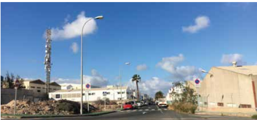
Antena de telecomunicaciones.
