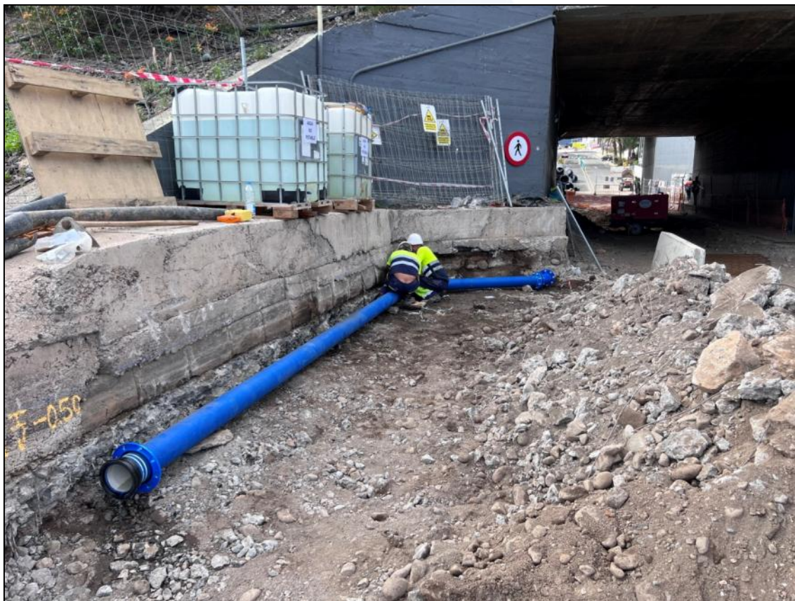
Fig. 3-Trabajos de desvío de conducciones de agua de abasto.
