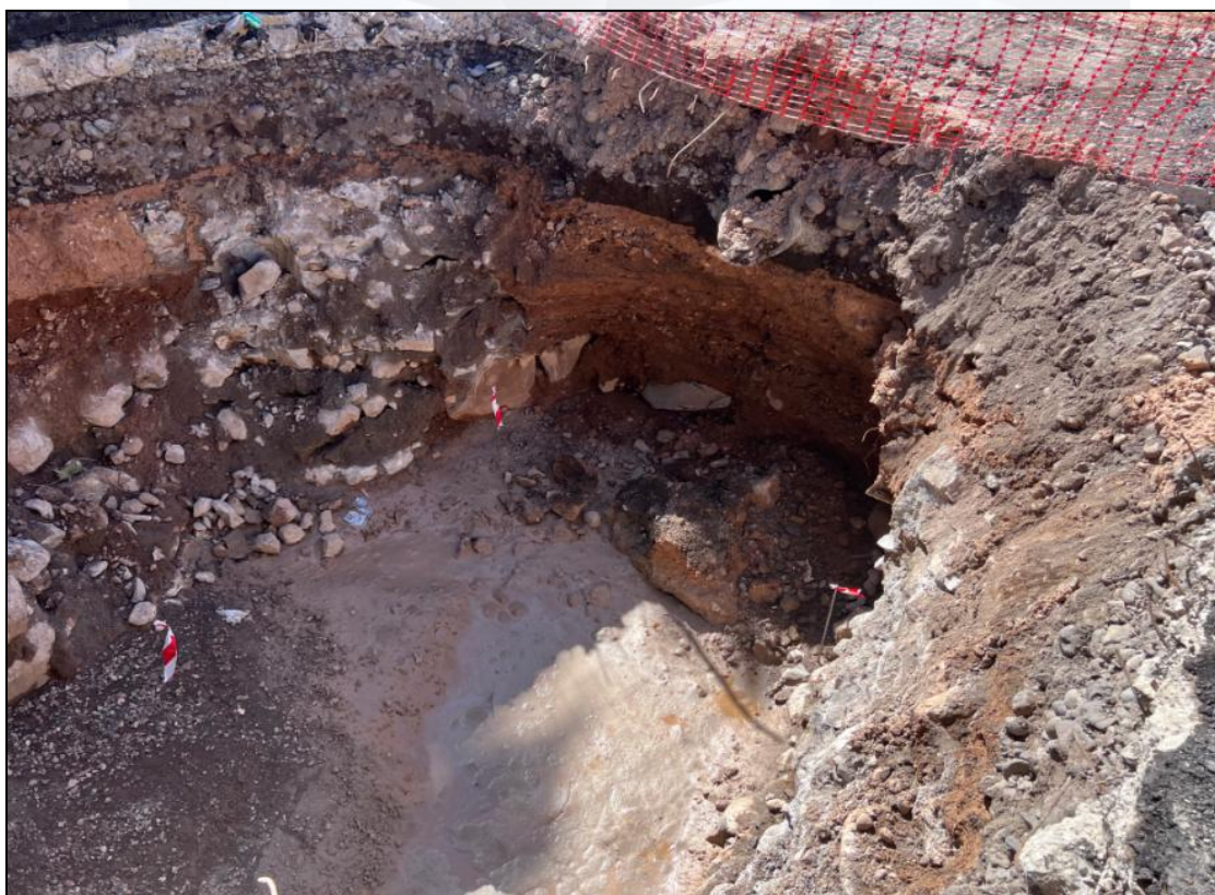
Fig. 6- Descalce de talud de la excavación al retirar en primera instancia un pequeño tramo del muro de mampostería hallado.
