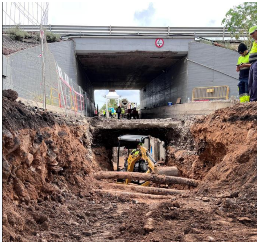
Fig. 7- Trabajos de retirada de material cercano a las conducciones de combustible.
