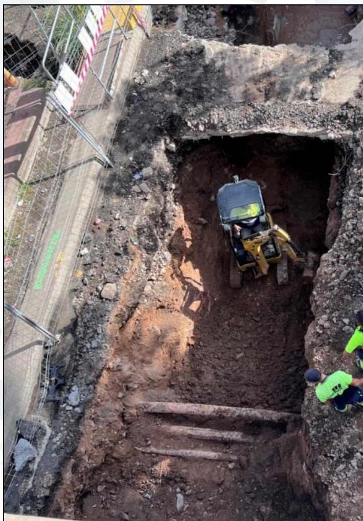
Fig. 6- Conducciones antiguas de combustible (parte baja de la foto).
