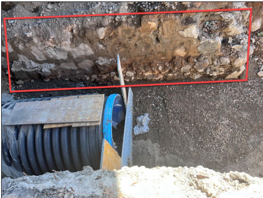
Fig. 5- Muros de mampostería a ambos lados de las estructuras.
