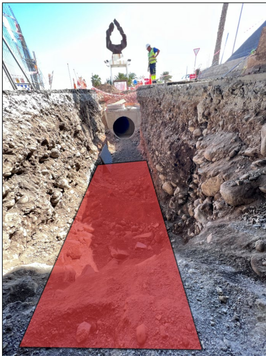
Fig. 4- Zona aproximada donde se encontró a la cota -3,5m, el prisma de hormigón de 1m de canto.
