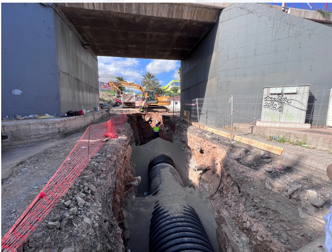
Fig. 2- Instalación de conducción en la calle Bosque, bajo la vía GC-1
