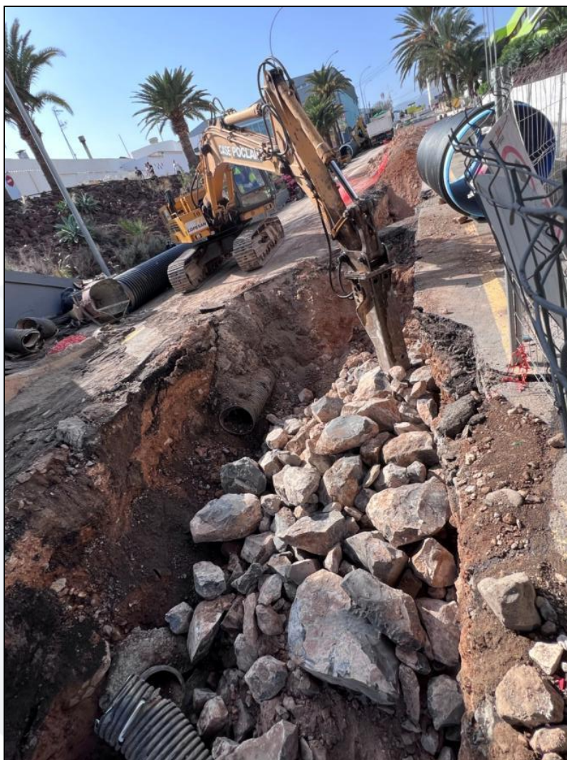
Fig. 11- Trabajos de retirada de basalto (roca de gran dureza).
