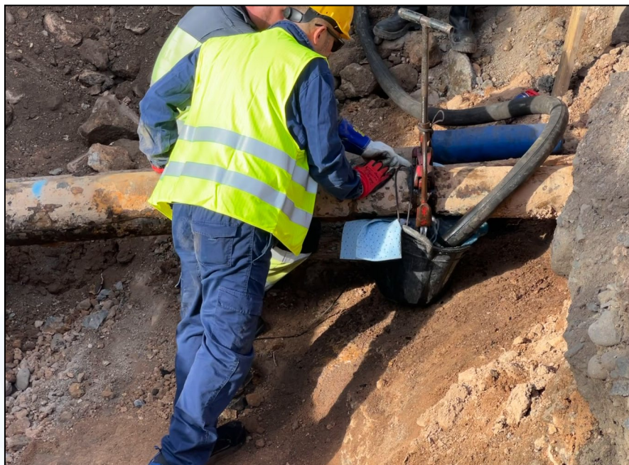
Fig. 9- Vaciado y corte manual, en frío, de las conducciones.
