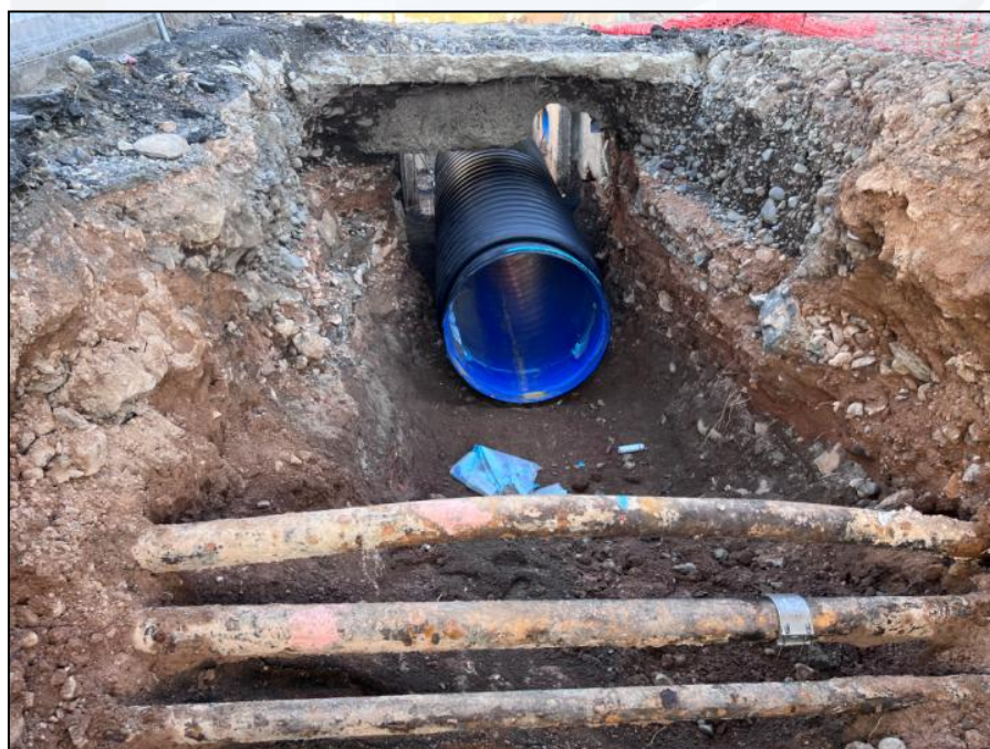
Fig. 8- Conducciones preparadas para su vaciado, corte, y retirada.
